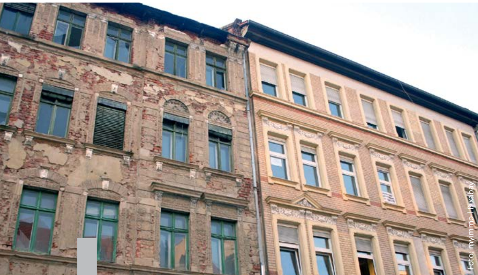
Die Bundesförderung für effiziente Gebäude (BEG) kann dieses Jahr starten.
