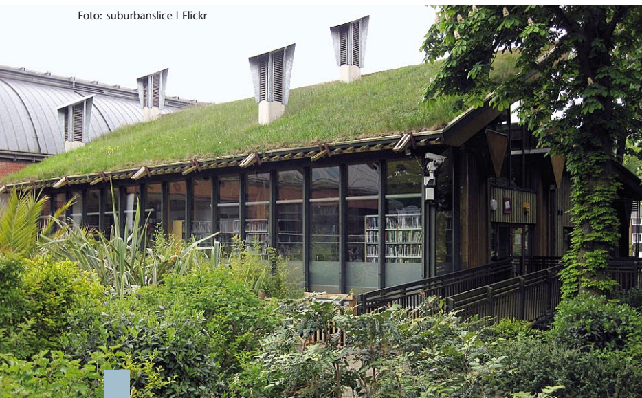
Umweltgerechtes Bauen wird weltweit immer wichtiger. Oben: Centre for Understanding the Environment in London.
